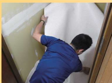
クロス張替えはトイレ空間と同じ条件で実習します。
